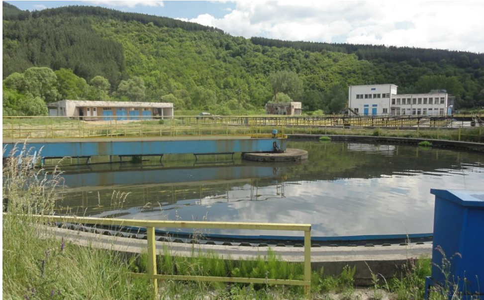
Фиг. 6. Пречиствателна станция за отпадъчни води Батановци.
